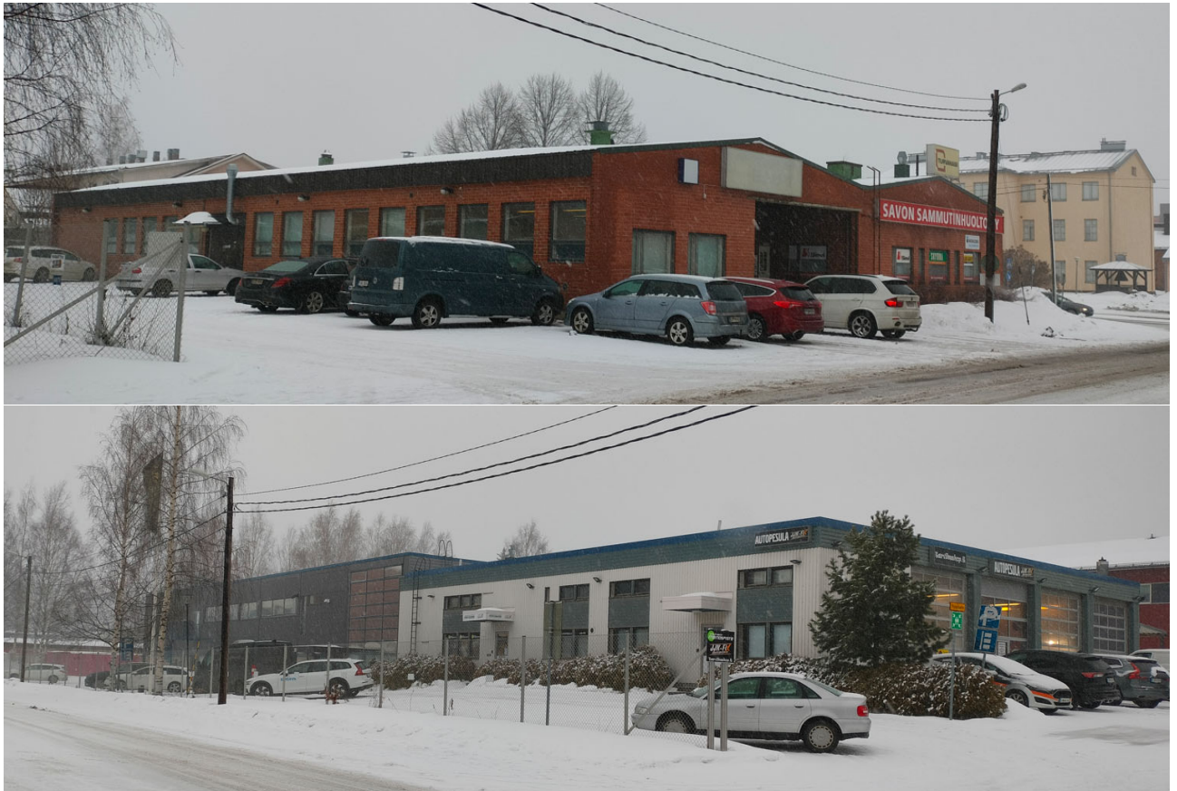
Kuva 3. Teollisuuskatu 1 (ylhällä) ja Teollisuuskatu 3-5 (alla).
